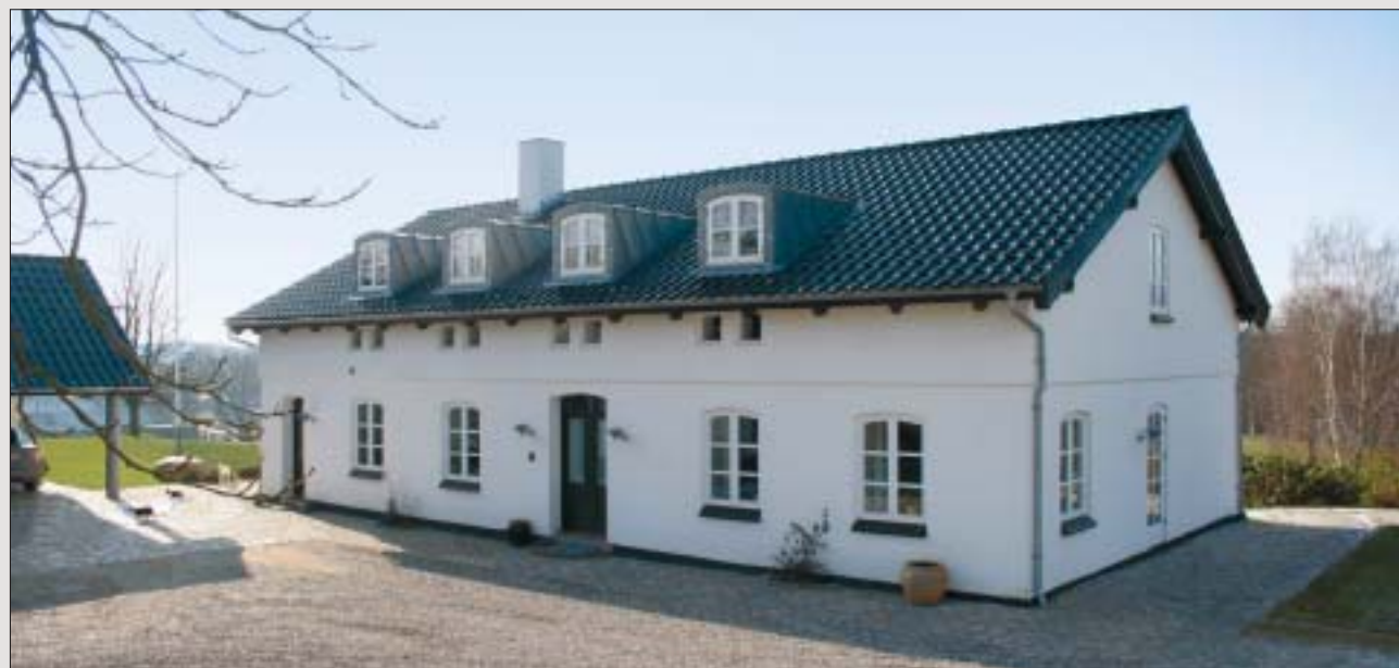
Materialerne klæder hinanden. Husets hvide mure, tagkonstruktionens sortglaserede sten og de rustikke grå zinkinddækninger omkring vinduerne danner tilsammen en moderne og gennemtænkt helhed.
